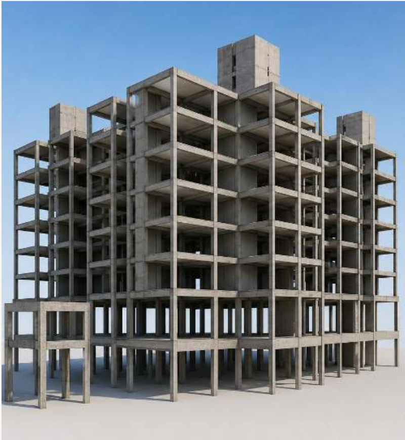
Prédio Residencial – Alagoinhas/Ba
